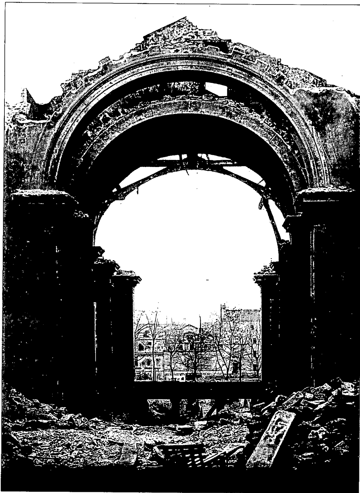
Sainte-Pélagie, la chapelle en démolition, vue du Nord, [1899].
